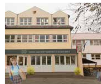
A korszerű épületenergetikai megoldások hatására jelentősen csökken a Taksony Vezér Általános Iskola üzemeltetési költsége
